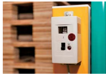
感震装置の取り付け例
