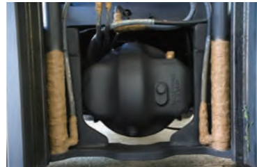
4 油圧ホースをオイルテープで防水処理。
