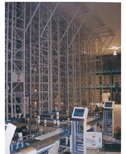
現場での安全施工を実施
