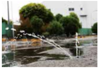
積雪対策に消雪パイプを設置
